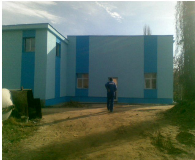
Stație tratare apă Oltenița
