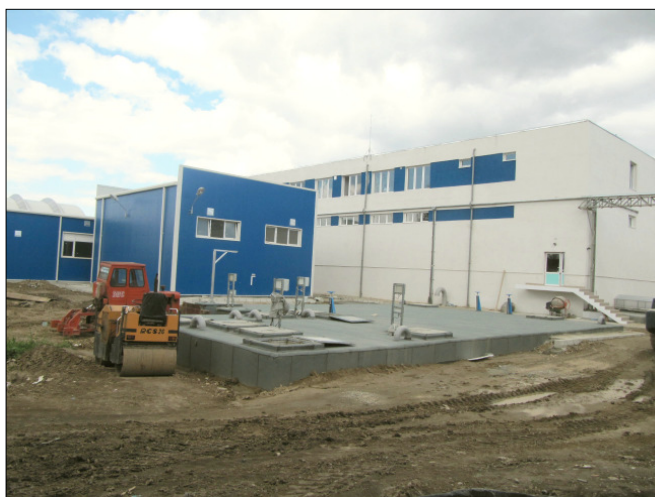
Vedere generală a obiectivelor noi
